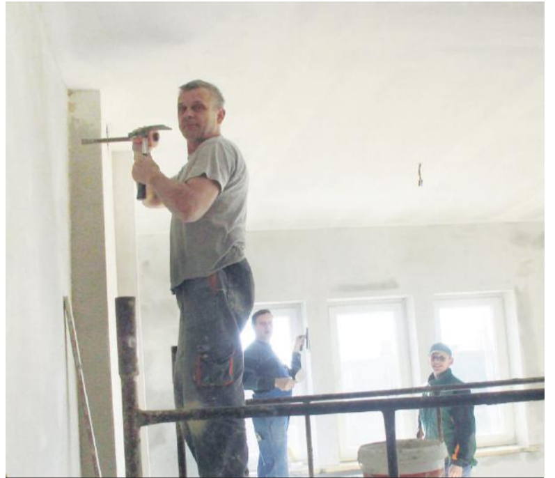
W trakcie prac budowlanych, marzec br. (Kaliszkowice Kaliskie)
