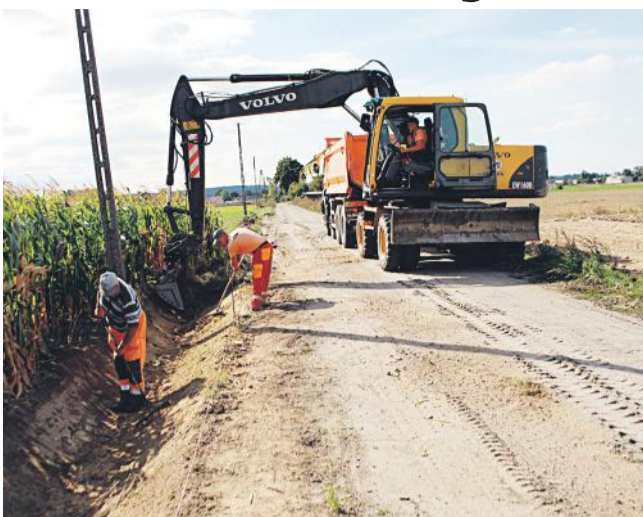
„Madera” w Kaliszkowicach Kaliskich będzie miała asfaltową nawierzchnię.
