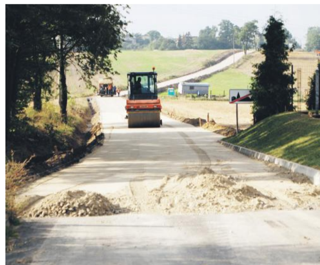
Modernizacja starej drogi z Komorowa.
