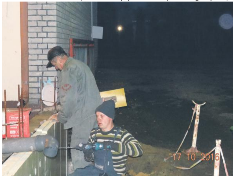
Zdjęcie z placu budowy, fot. M. Czwordon
