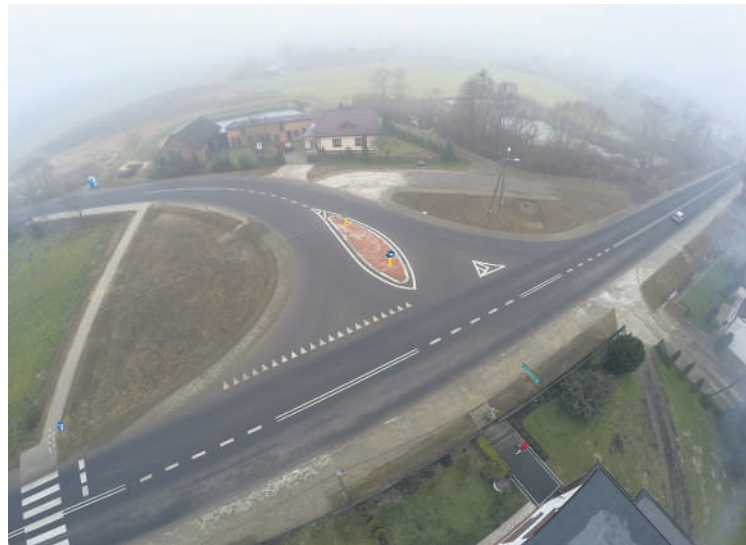
dysz. - Chcę podziękować za tę drogę, która łączy drogę wojewódzką z „eską” i bo tu się rozpoczęła przebudowa drogi, dla nas to jest praktycznie okno na świat
